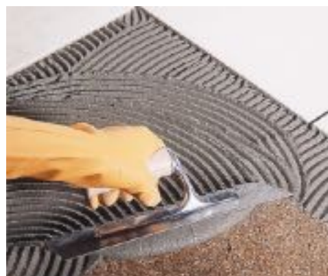
Posa a rivestimento di piastrelle in monocottura su sughero
