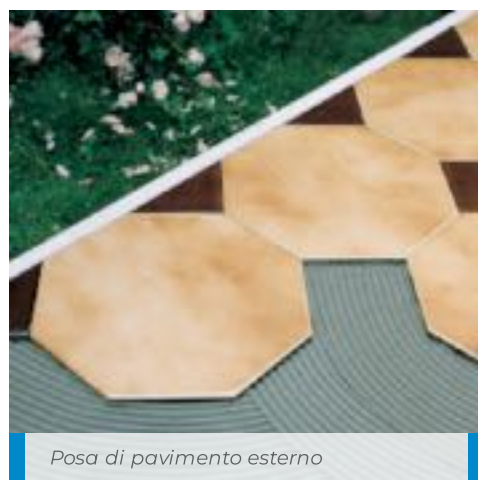
Posa a rivestimento di piastrelle in monocottura su sughero
