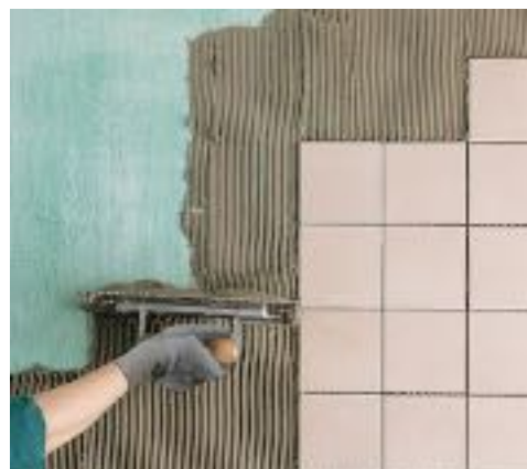
Posa su gesso trattato con Primer G
